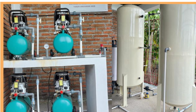
INSTALASI PERPIPAAN GAS RAWA
