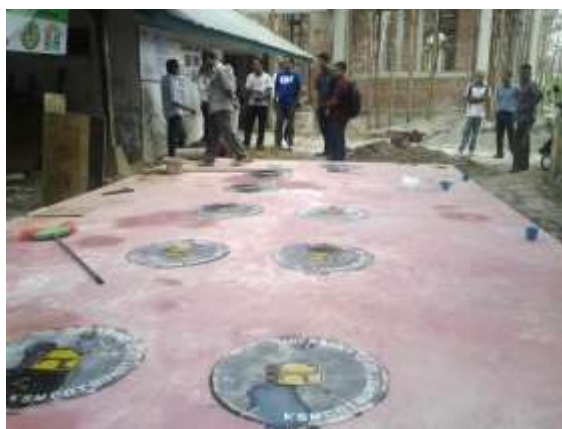
Pembangunan IPAL Komunal KSM Cot Bunot, Kecamatan Barona Jaya, Kabupaten Aceh Besar
