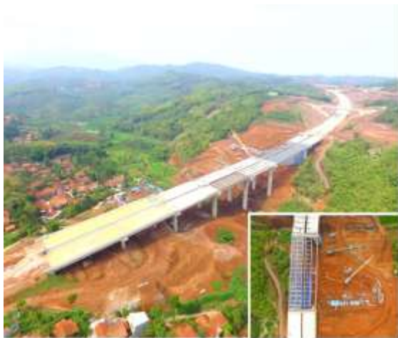
Pembangunan Jembatan Cisarongge Sumber : Kementerian Pekerjaan Umum dan Perumahan Rakyat
