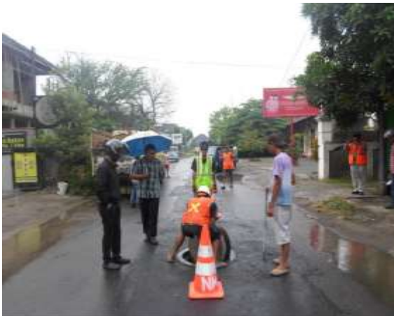
Pemeriksaan serah terima pekerjaan pertama Ruas 6 (Urip Sumoharjo), Yogyakarta
