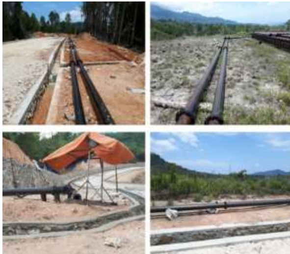
Pelaksanaan pekerjaan waterline system (Sumber : PT. PLN)
