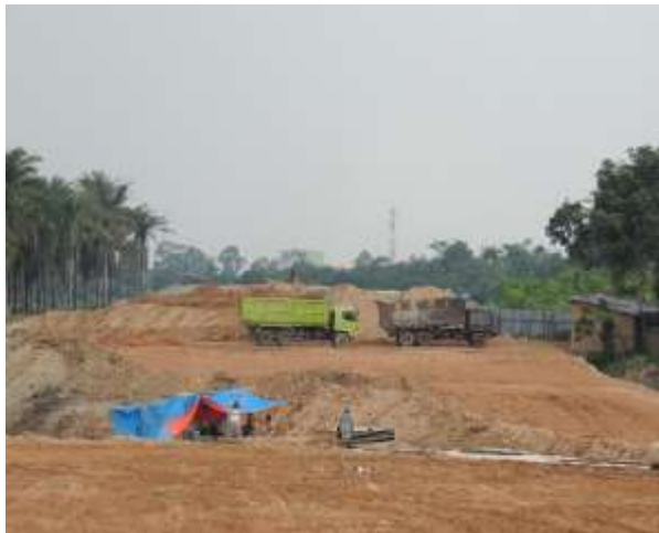
Pengerukan soft soil dan penimbunan tanah untuk pematatan
