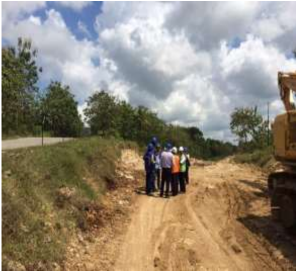
Pelaksanaan Pembangunan Jalan pada Sta 18+000 Komponen 24-RCP02
