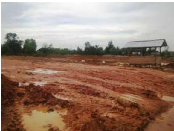
Lahan yang dipersiapkan untuk pembangunan fisik
