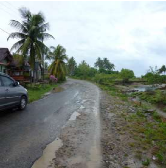
Ruas Jalan Krui-Biha Lampung Sumber: Website Proyek WINRIP ( www.winrip-ibrd.com )
