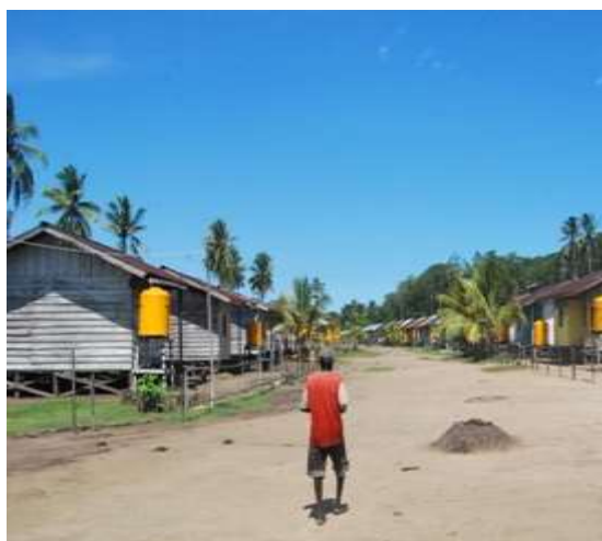
Pengadaan Profil Tank (penampungan air bersih) di perkampungan Timika Pantai Distrik Mimika Timur Tengah-Kabupaten Mimika-Papua Sumber : www.antaranews.com
