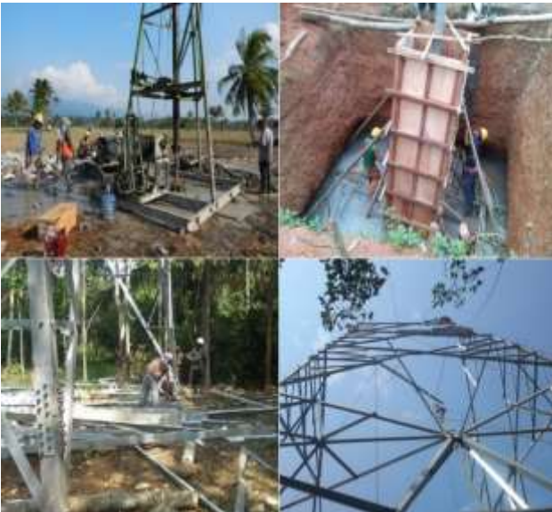
Pekerjaan Transmission Line (Sumber : PT. PLN)
