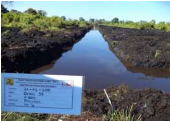
Earthworks-Penggalian kanal serapan (D.39)
