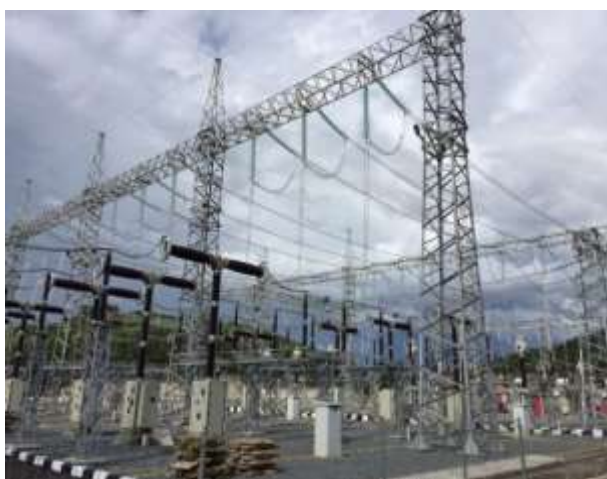
Pembangunan Substation Bengkayang
