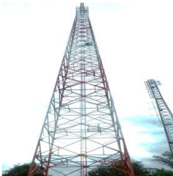
Menara di lokasi Sidempuan – Sumatera Utara Sumber : Kementerian Komunikasi dan Informatika
