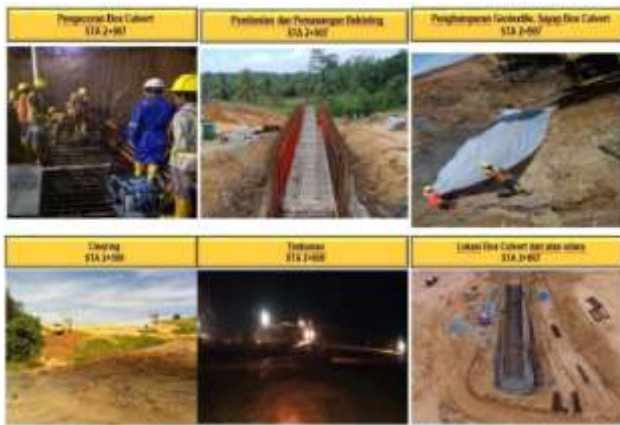
Pelaksanaan Pembangunan Jalan Tol Balikpapan-Samarinda (MYC) Seksi V
