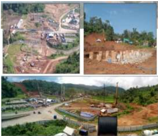
Pembangunan Jembatan Cinapel
