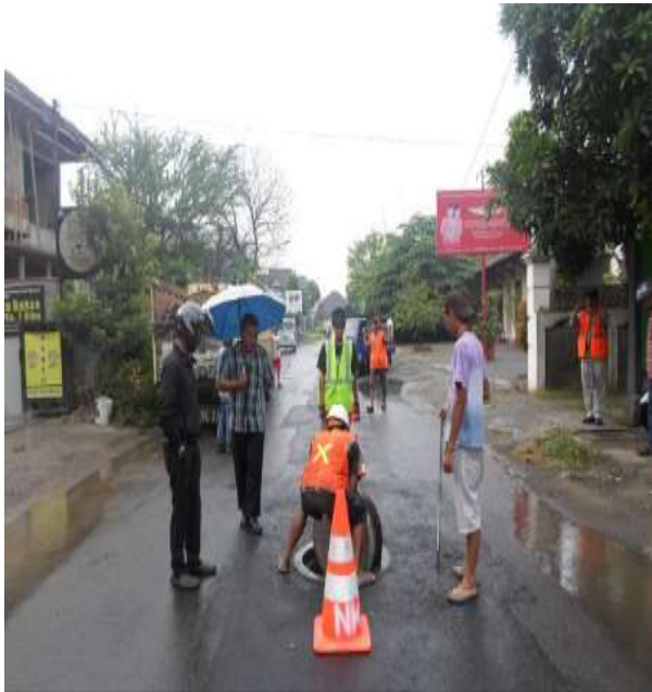
Pemeriksaan serah terima pekerjaan pertama Ruas 6 (Urip Sumoharjo), Yogyakarta
