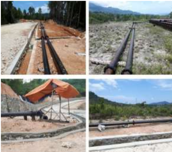
Pelaksanaan pekerjaan waterline system (Sumber : PT. PLN)
