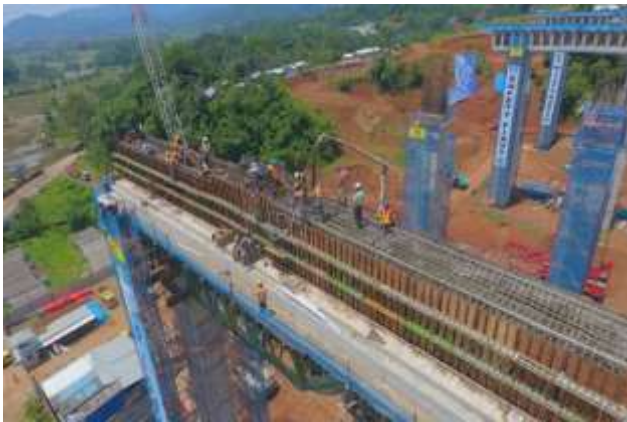
Pembangunan Jembatan Cinapel Sumber : Kementerian Pekerjaan Umum dan Perumahan Rakyat
