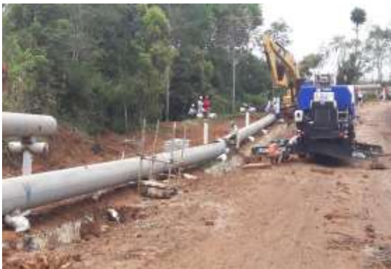
Pekerjaan Pemasangan Pipa Sumber: Kunjungan Lapangan Kemen PPN/Bappenas
