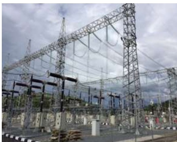
Pembangunan Substation Bengkayang
