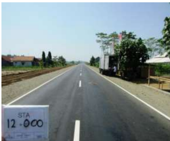
Pelaksanaan Pembangunan Jalan pada Sta 12+000 (RCP-03)
