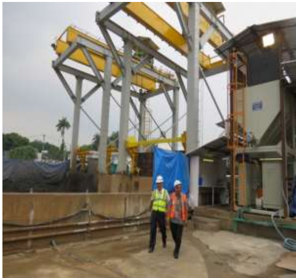
Pekerjaan sipil Proyek MRT Sumber : Kunjungan lapangan Bappenas
