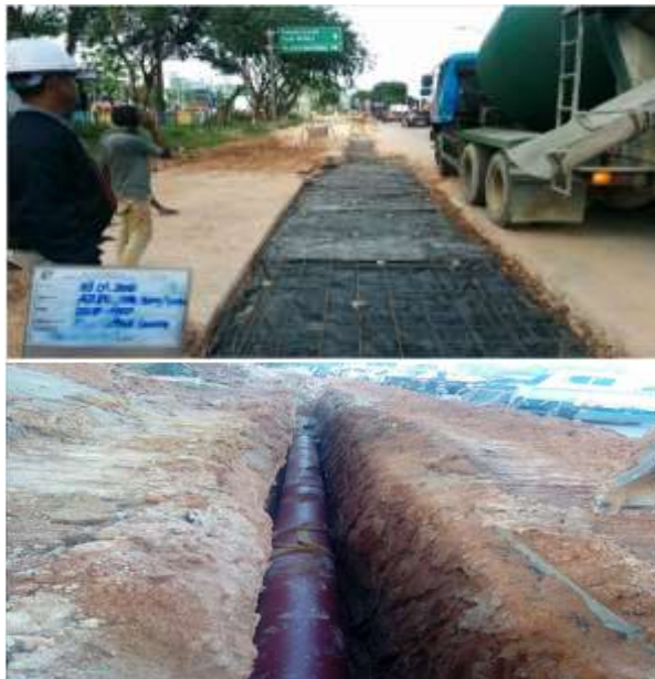
Pemasangan Pipa Primer Di Jalan Utama Sumber : Badan Pengusahaan Batam
