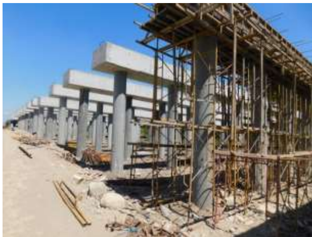
Pembangunan Jembatan Sumber: Kunjungan Lapangan Kementerian PPN/Bappenas
