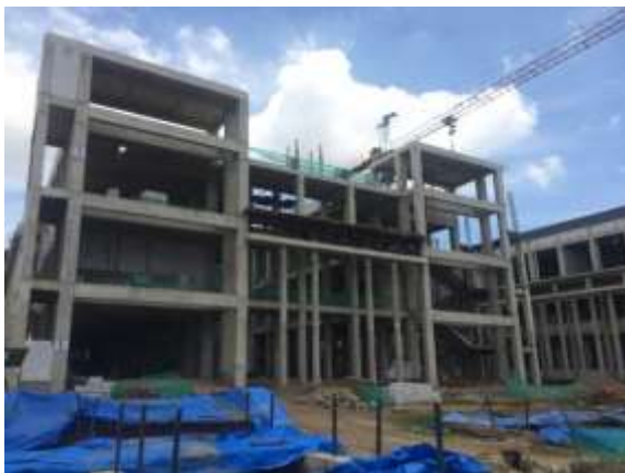
Pembangunan Fakultas MIPA Blok F di Unsyiah
