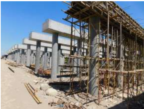
Perkembangan pelaksanaan pembangunan jembatan di sungai mati
