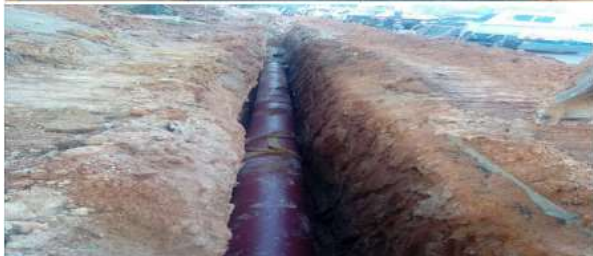
Pemasangan Pipa Primer Di Jalan Utama Sumber : Badan Pengusahaan Batam
