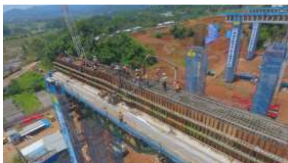
Pembangunan Jembatan Cinapel
