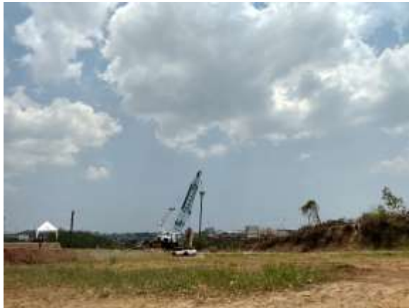
Persiapan lahan untuk pembangunan fisik UIN Walisongo Semarang
