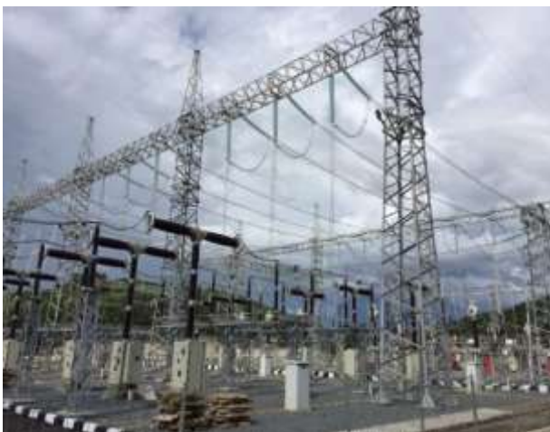
Pembangunan Substation Bengkayang
