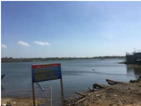
Lokasi Rencana Pembangunan Lot 3 Jembatan Kretek 2
