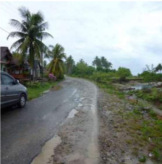
Ruas Jalan Krui-Biha Lampung
