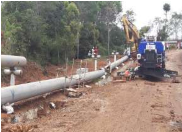
Pekerjaan Penyambungan Pipa di Lumut Balai Sumber : Kunjungan Lapangan Bappenas
