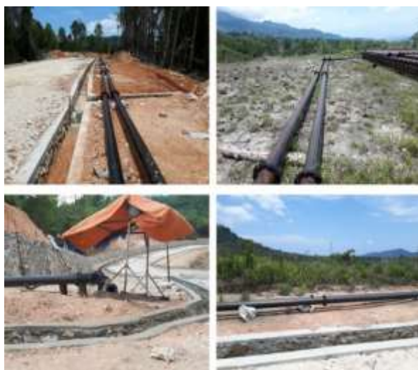
Pelaksanaan pekerjaan waterline system (Sumber : PT. PLN)
