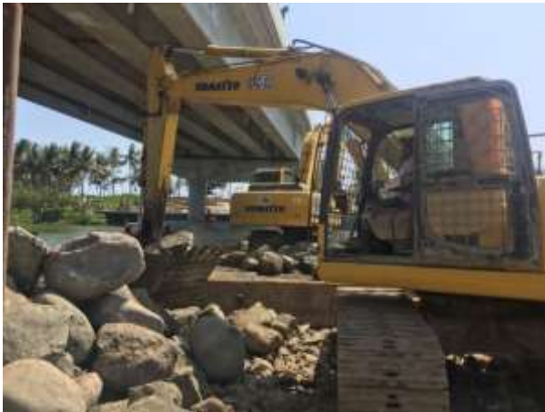
Pelaksanaan Pekerjaan Proteksi Jembatan di 24-RCP-01 Tambakmulyo-Wawar
