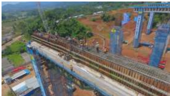
Pembangunan Jembatan Cinapel Sumber : Kementerian Pekerjaan Umum dan Perumahan Rakyat
