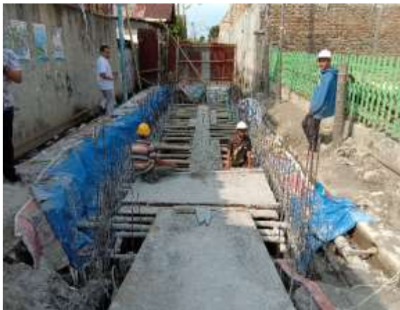
Pembangunan IPAL Komunal Lingkungan III Kel. Tegal Sari 3, Kota Medan
