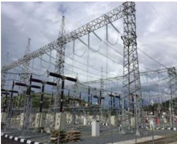
Pembangunan Substation Bengkayang
