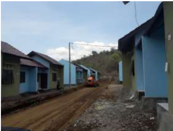
Pembangunan NSD di Kota Bima
