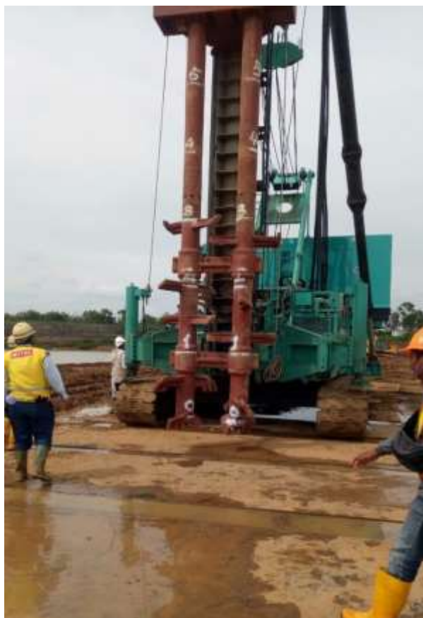
Pengerasan Tanah untuk mendukung tanggul menggunakan teknologi DMSI.
