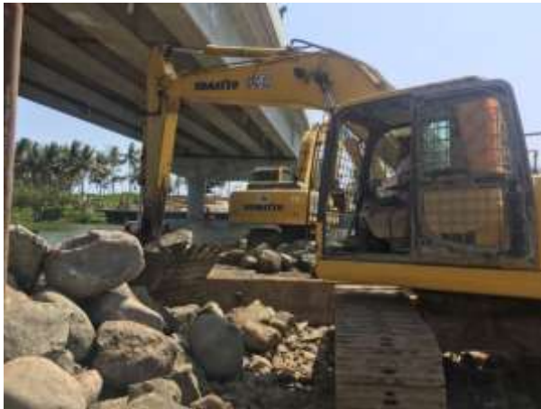
Pelaksanaan Pekerjaan Proteksi Jembatan di 24-RCP-01 Tambakmulyo-Wawar
