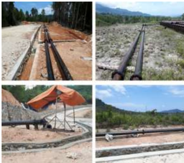
Pelaksanaan pekerjaan waterline system (Sumber : PT. PLN)
