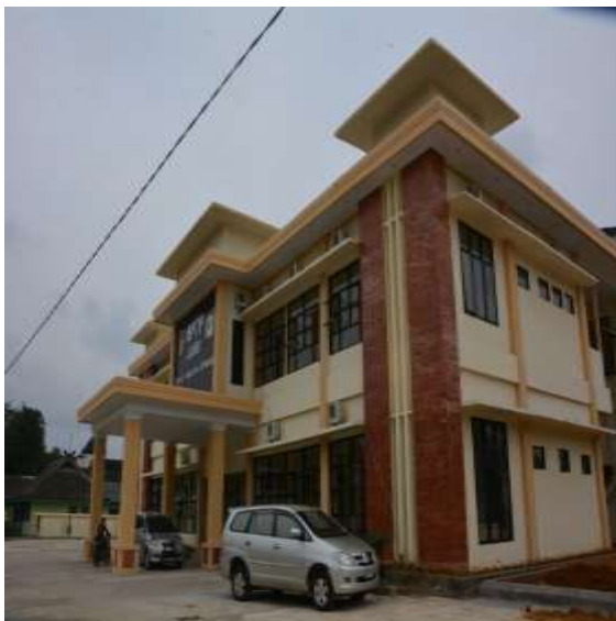
Gedung BPTP Jambi Sumber: Website proyek SMART-D
