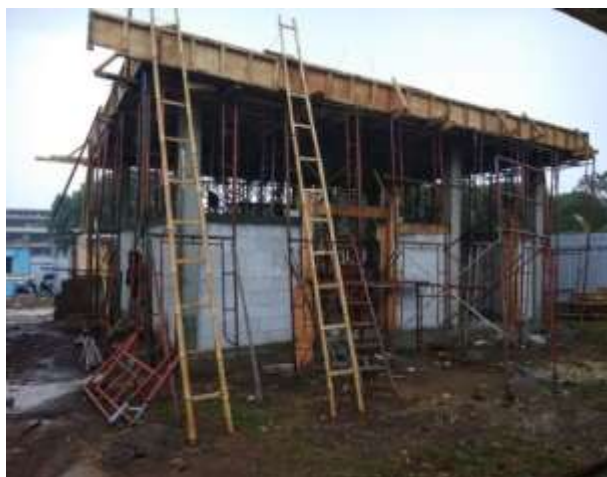
Pembangunan Ruang Genset BSL-3
