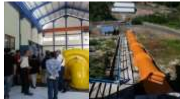
Gambar 2. Gedung PLTA dan Pipa PLTA Ndungga
