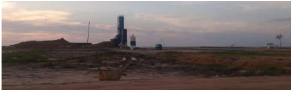
Gambar 1. Kondisi Lapangan Proyek PLTU Parit Baru
