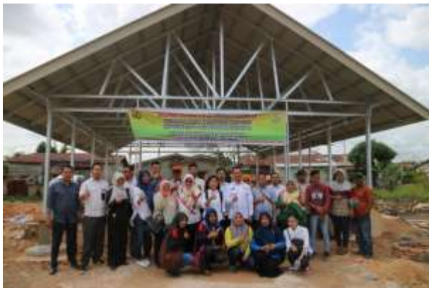
Kunjungan Lapangan lokasi IPAL di Riau
