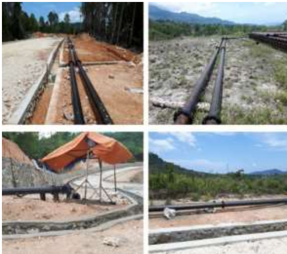
Pelaksanaan pekerjaan waterline system (Sumber : PT. PLN)
