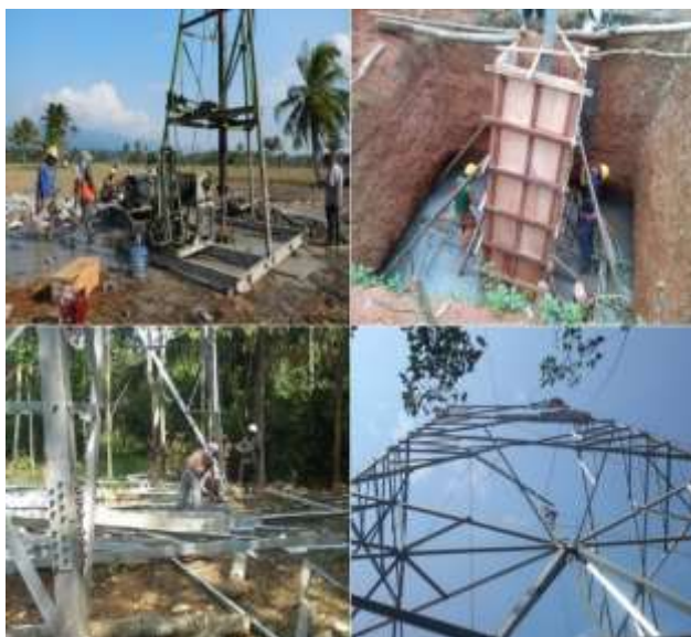
Pekerjaan Transmission Line (Sumber : PT. PLN)
