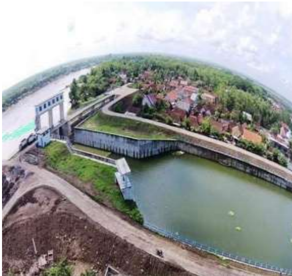
Foto udara inlet struktur
