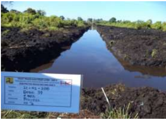
Earthworks-Penggalian kanal serapan (D.39)
