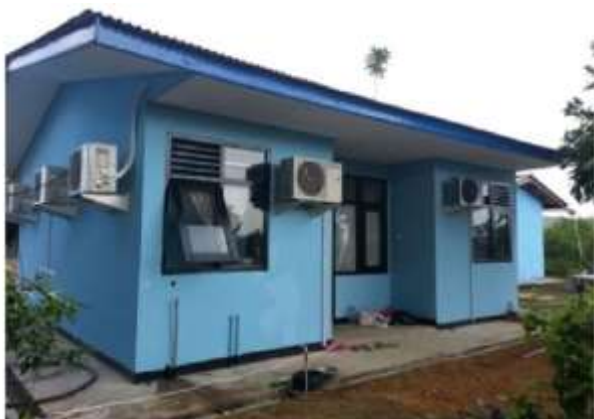
Rehabilitasi Gedung Ruang Pemancar Kijang – Kepri Sumber : Kementerian Komunikasi dan Informatika
