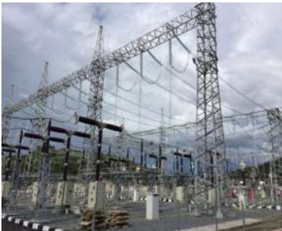
Pembangunan Substation Bengkayang
