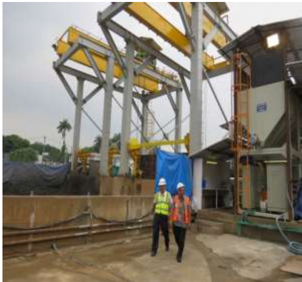
Pekerjaan sipil bawah tanah Sumber : Kunjungan lapangan Bappenas
