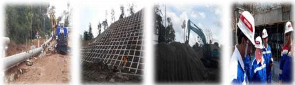
Gambar 2.5. Dokumentasi Kunjungan ke Lokasi Proyek Lumut Balai Geothermal Power Plant
