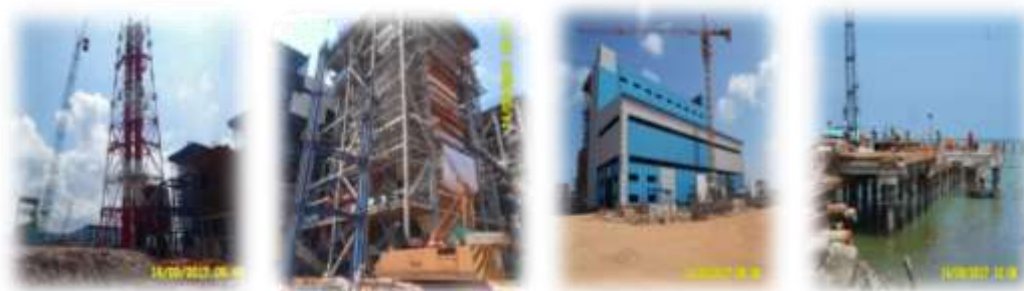
Gambar 2.6. Dokumentasi Kunjungan ke Lokasi Proyek Parit Baru Coal Fired Steam Power Plant
