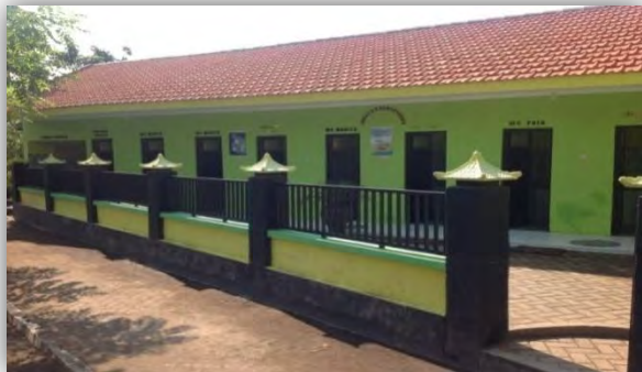
Pembangunan MCK di Kelurahan Kepel, Kabupaten Pasuruan
