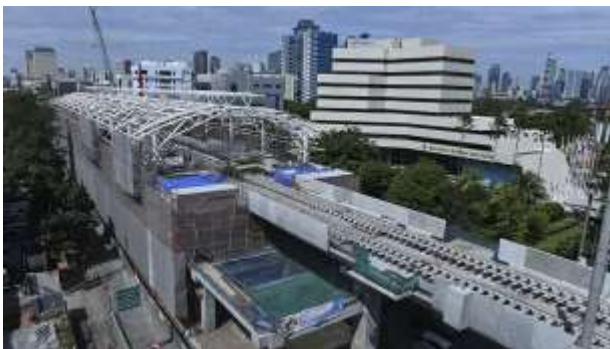
Pekerja mengerjakan proyek pembangunan stasiun layang MRT di Jalan Sisingamangaraja Sumber : www.jakartamrt.co.id
