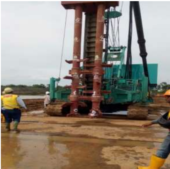
Pengerasan tanah untuk mendukung tanggul menggunakan teknologi DMSI
