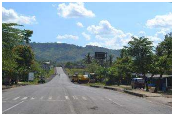
Civil Work 2: Giriwoyo-Duwet yang telah selesai dikerjakan
