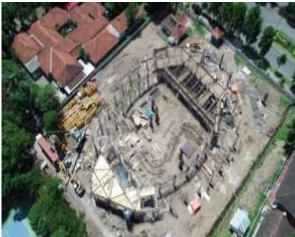
Pembangunan Auditorium Universitas Jember
