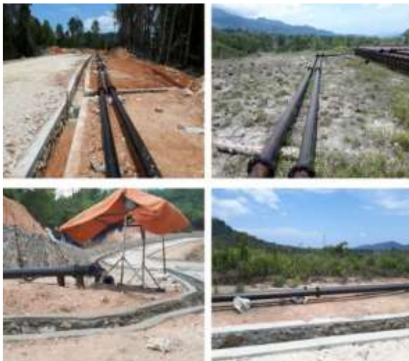
Pelaksanaan pekerjaan waterline system (Sumber : PT. PLN)
