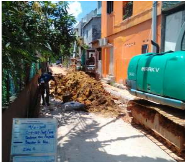
Pengalihan tanah untuk instalasi pipa Sumber : Badan Pengusahaan Batam
