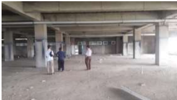
Kondisi Gedung RS Unhas
