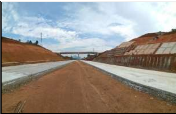
Cigemblung Overpass Sumber : Kementerian Pekerjaan Umum dan Perumahan Rakyat
