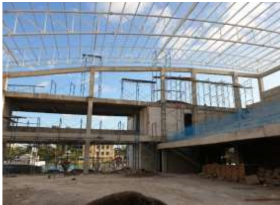
Pelaksanaan pembangunan gedung baru UIN Mataram
