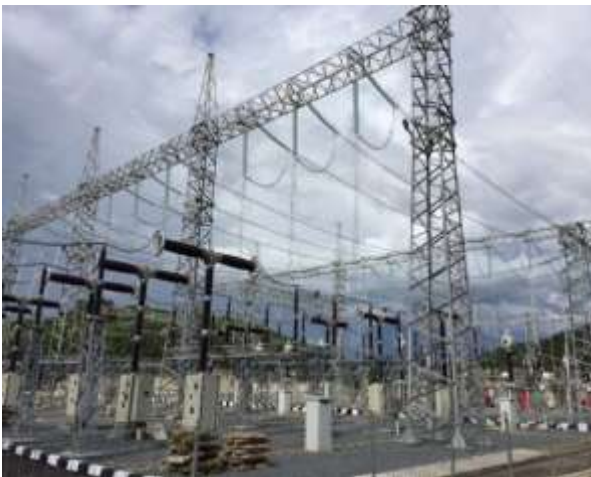
Pembangunan Substation Bengkayang
