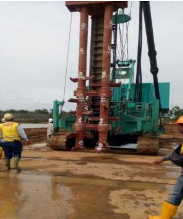
Pengerasan tanah untuk mendukung tanggul menggunakan teknologi DMSI.
