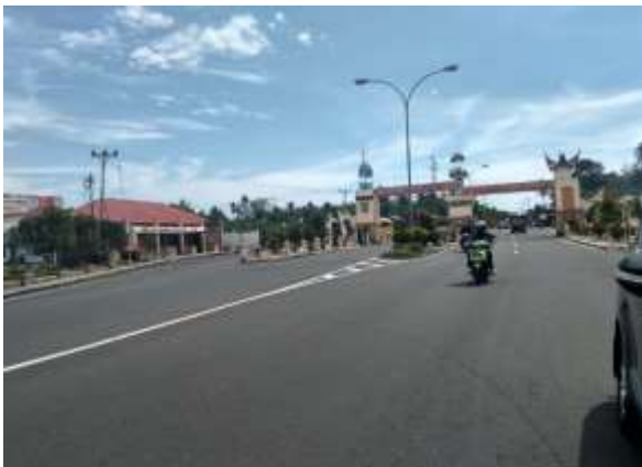
Kondisi Jalan Paket 8 di batas Kota Pariaman - Manggopoh (Sumatera barat)
