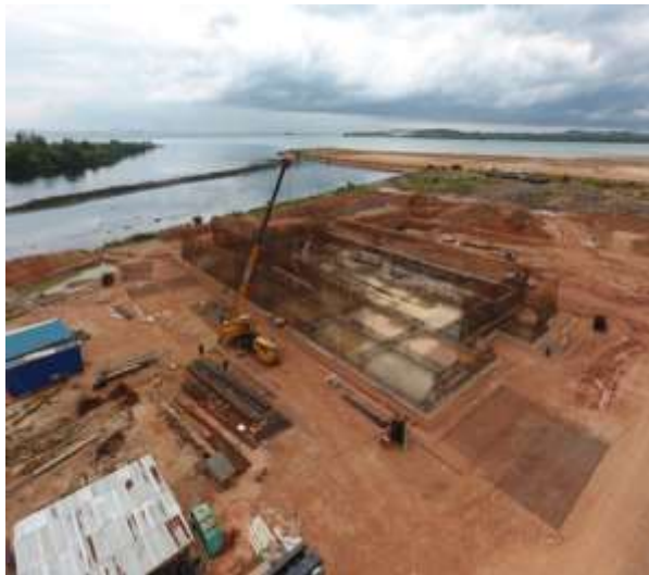
Pembangunan Wastewater Treatment Plan (WWTP) Sumber : Badan Pengusahaan Batam
