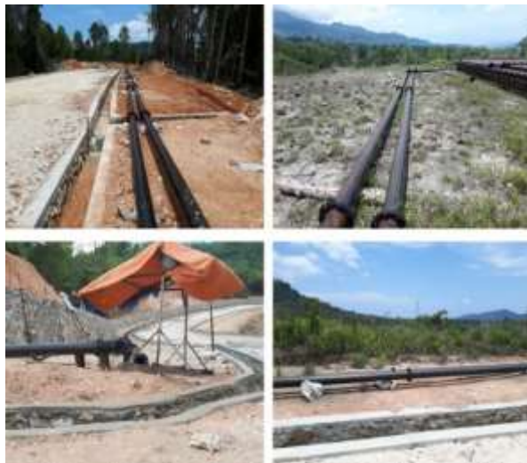
Pelaksanaan pekerjaan waterline system (Sumber : PT. PLN)
