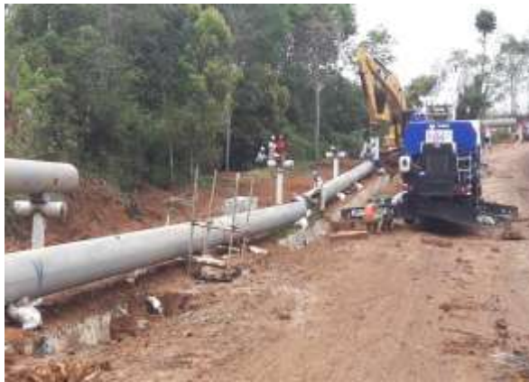
Pekerjaan Penyambungan Pipa di Lumut Balai Sumber : Kunjungan Lapangan Bappenas
