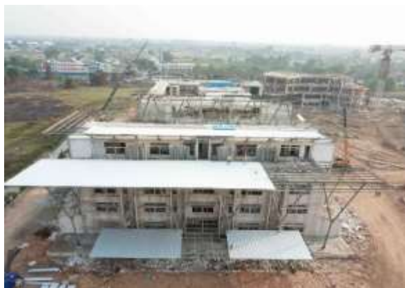
Pelaksanaan pembangunan gedung Tarbiyah UIN Raden Fatah
