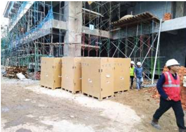
Pelaksanaan pekerjaan konstruksi gedung baru di Universitas Mulawarman
