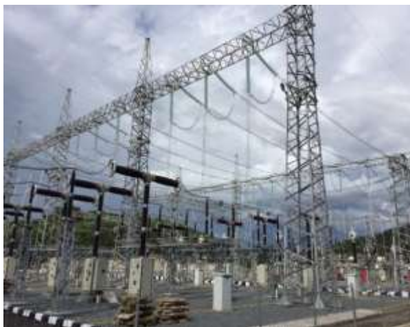
Pembangunan Substation Bengkayang
