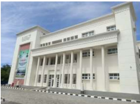
Gedung yang telah selesai dibangun di Universitas Syiah Kuala
