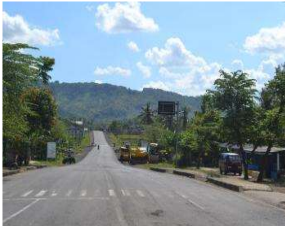
Civil Work 2: Giriwoyo-Duwet yang telah selesai dikerjakan
